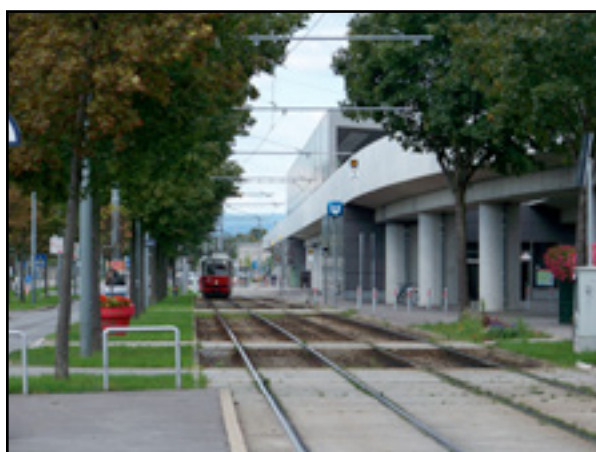
Obrázek 6: Při dostatku prostoru se staví metro levněji na estakádě (vpravo stanice), zdroj: archiv Auto*Mat
