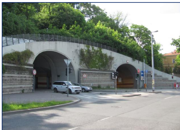
Výústí ramp tunelu Mrázovka do Radlické ulice
