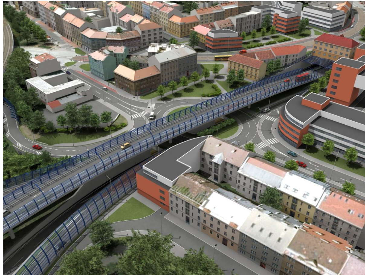
Obr. V.1.2-1 Křižovatka U Kříže po realizaci stavby č. 8313 Libeňská spojka
