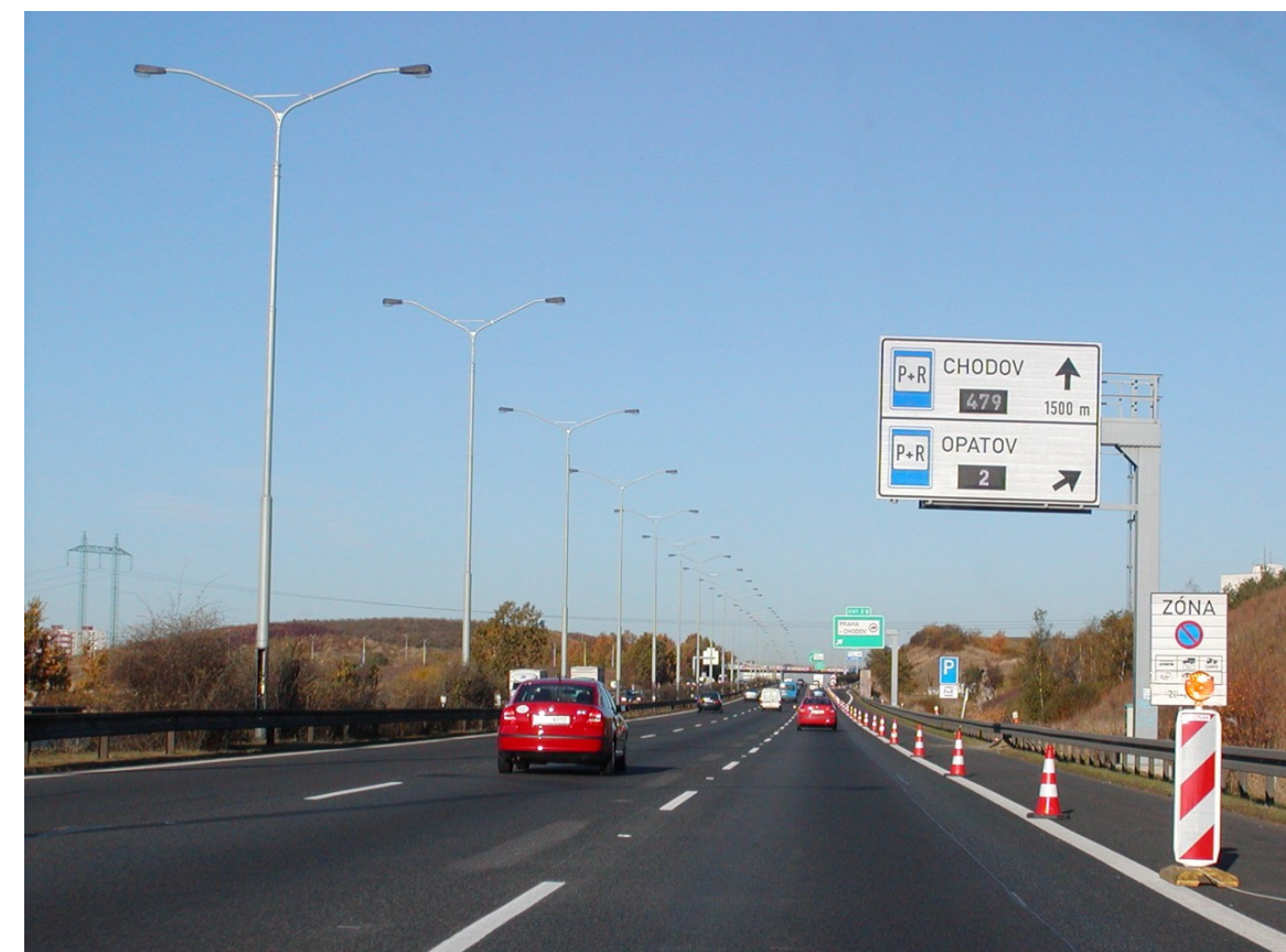
Obr. V.3.6-2 Informační tabule, dálnice D1
