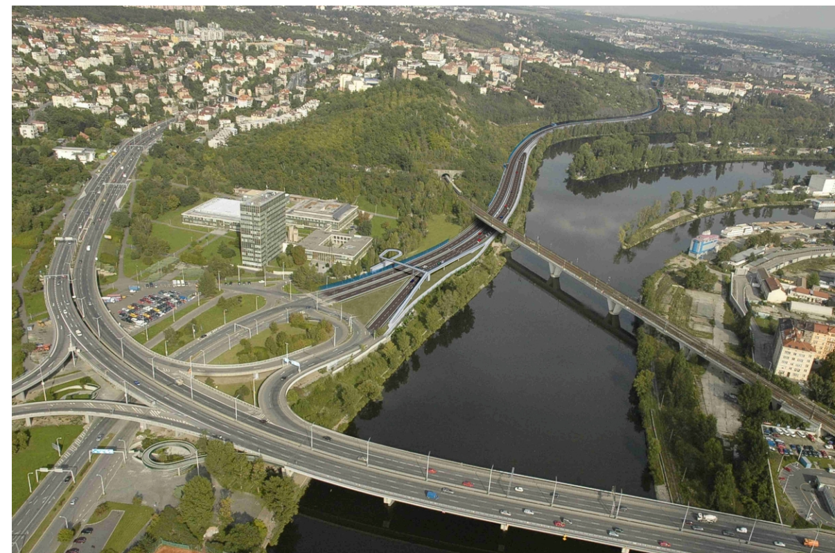
Obr. IV.6-6 Stavba MO č. 0081 Pelc–Tyrolka - Balaběnka
