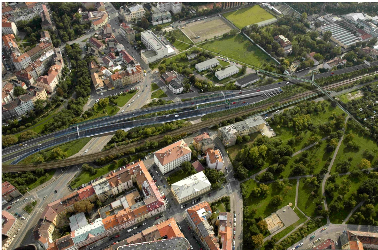
Obr. IV.6-5 Oblast Libně se stavbou MO č. 0081
