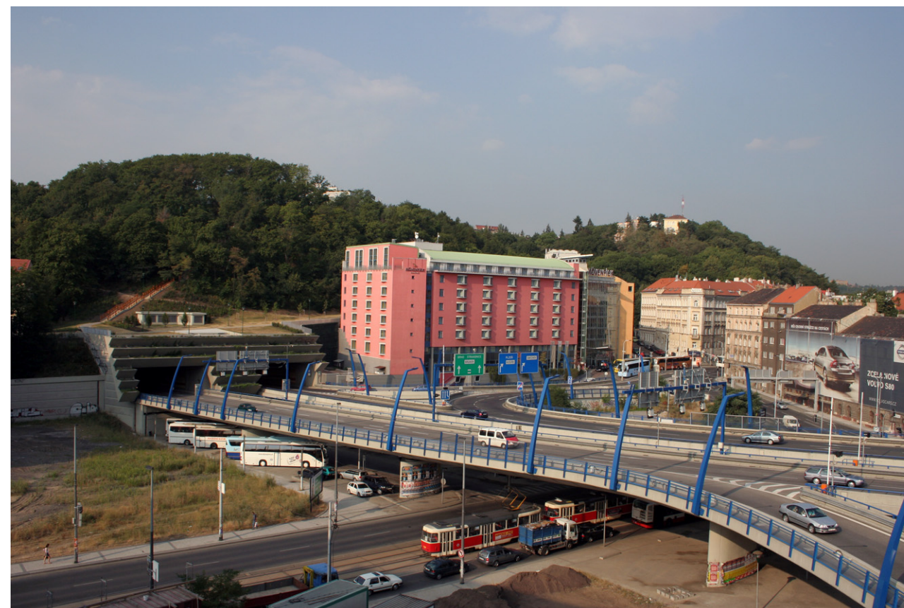
Obr. IX.16-1 Severní portály automobilového tunelu Mrázovka
