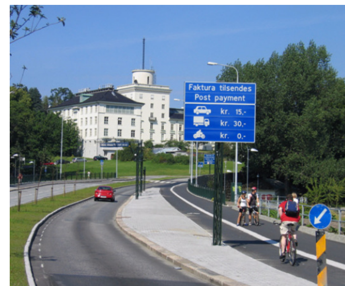
Obr. V.4.2.4-1 Bergen - plně automatický mýtný bod
